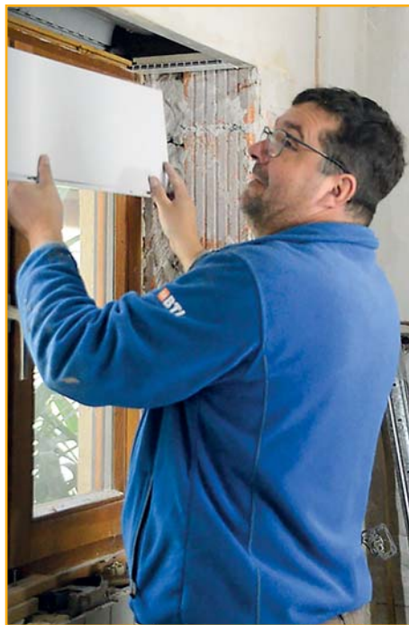
△ Stefan Sauer montiert eine neue Abdeckung für den Rolladenkasten.
